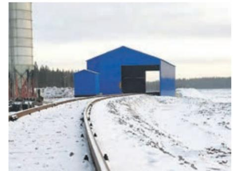
На терминале Пинежского ЛПК завершен монтаж навеса разгрузки цемента. Данное сооружение позволит беспрепятственно производить выгрузку цемента из вагона в любую погоду по пневматической системе прямо в силосы бетонного завода, что позволит значительно снизить трудозатраты на такелажные работы и тем самым снизить стоимость бетонной смеси, что особенно важно в преддверии строительства нового лесоперерабатывающего завода.
