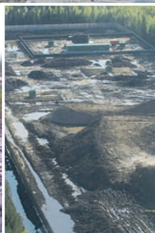
Фото пресс-службы регионального УМВД
