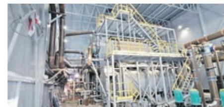
Устьянская теплоэнергетическая компания продолжает строительство котельной в поселке Сельменьга. На сегодня завершаются работы по строительству основного здания, а к концу февраля планируется установить все тепломеханические элементы, смонтировать трубопровод, выполнить монтаж двух теплообменников и проложить более ста метров теплотрассы. Запуск в эксплуатацию новой котельной мощностью 8 МВт планируется весной этого года.
